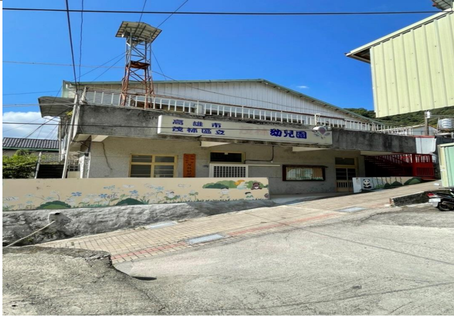
改善茂林區日照中心設置無障礙車道案
