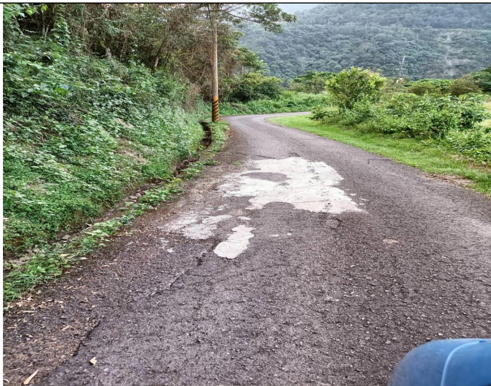
拓寬改善得恩谷道路並重新鋪設柏油路面案
