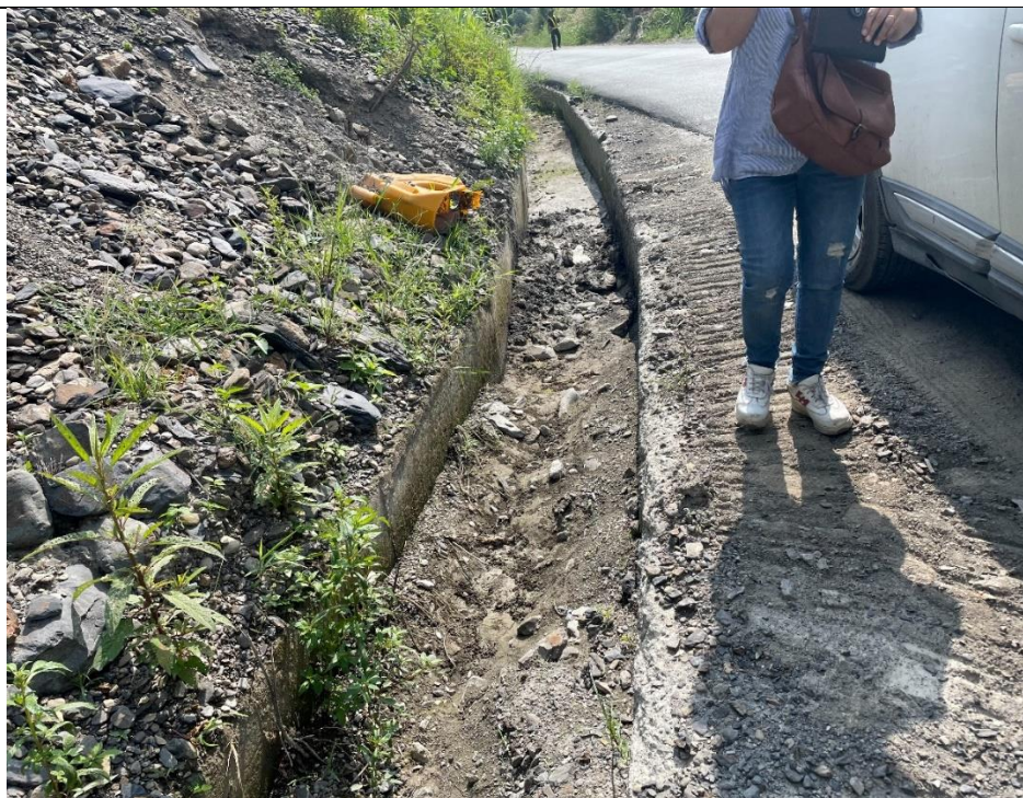
設格柵板排水溝蓋並於大排水溝處設置護欄案
