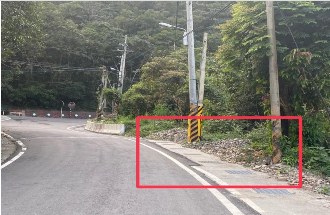
多納里部落路口意象路段旁加鋪水泥及設置護欄案
