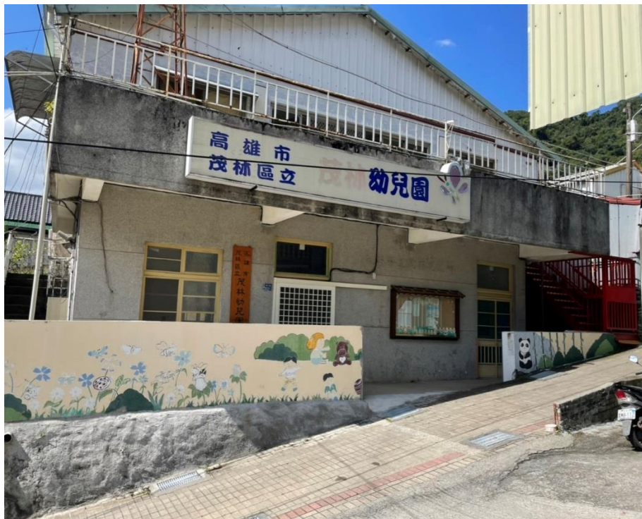
改善茂林區日照中心設置無障礙車道案
