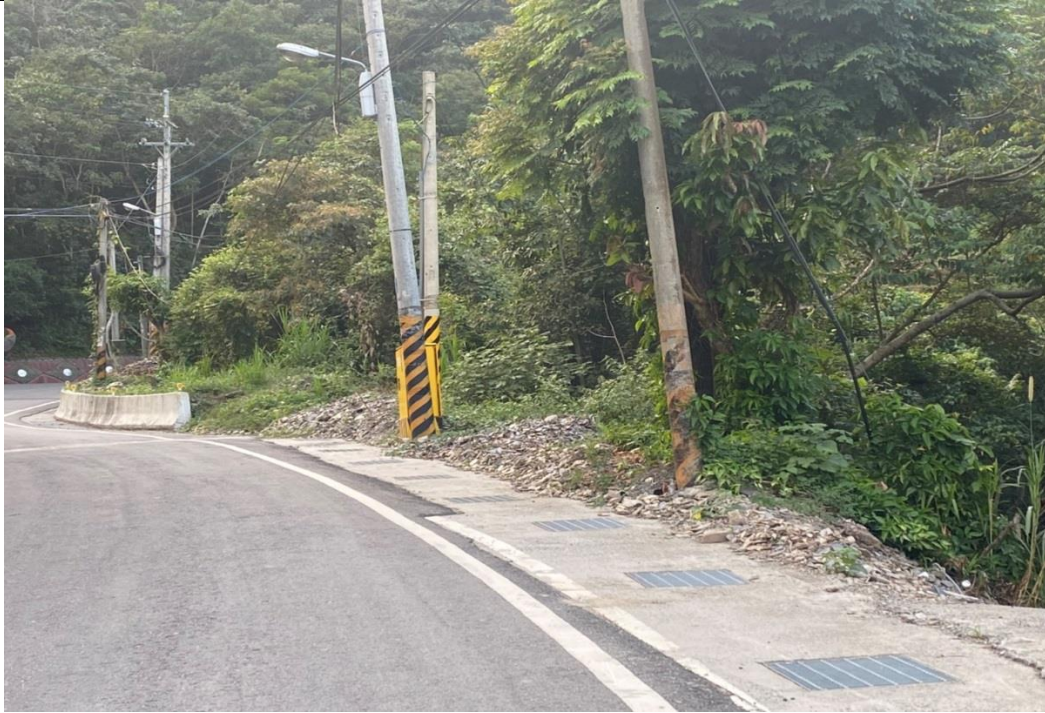
多納里部落路口意象路段旁加鋪水泥及設置護欄案
