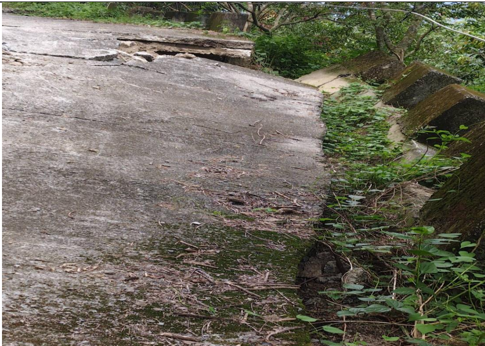
茂林後山產業道路面多處龜裂滑動下陷
