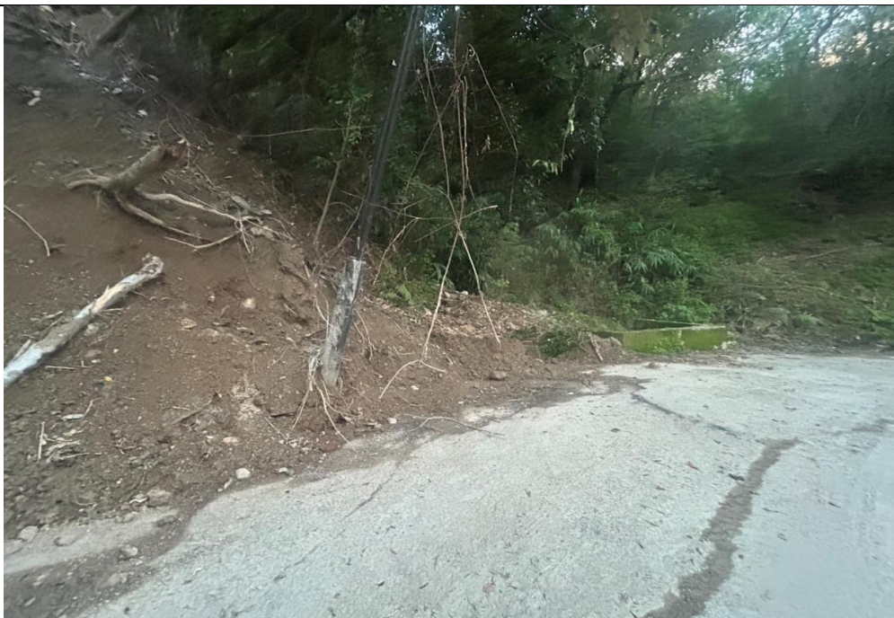
07/28 豪雨多納往高吊橋方向（小長城露營區）下方聯絡道路造成上方土石崩落案
