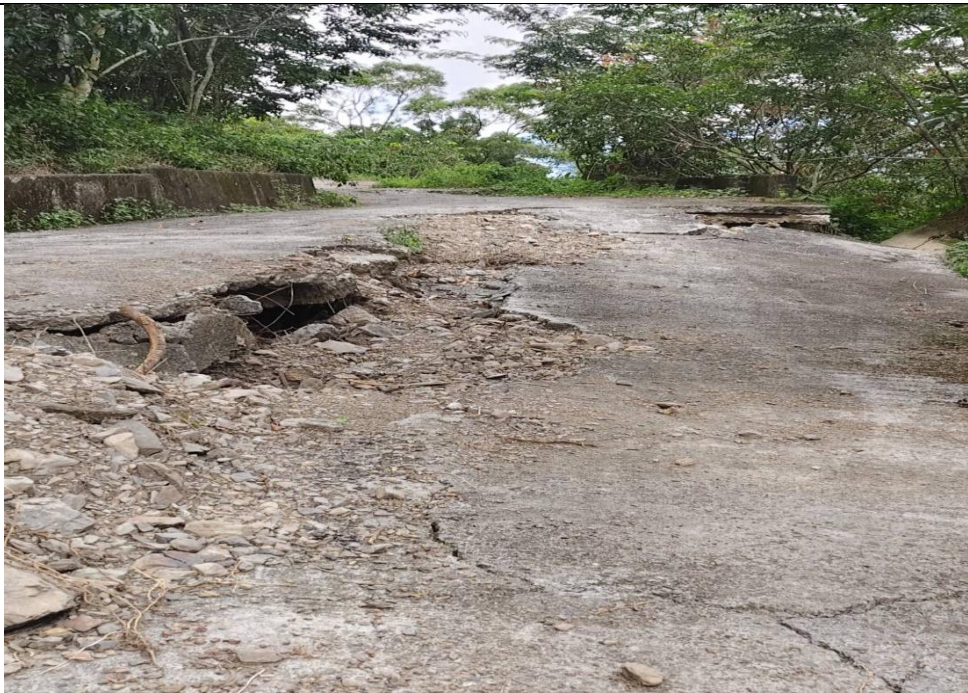
茂林後山產業道路面多處龜裂滑動下陷
