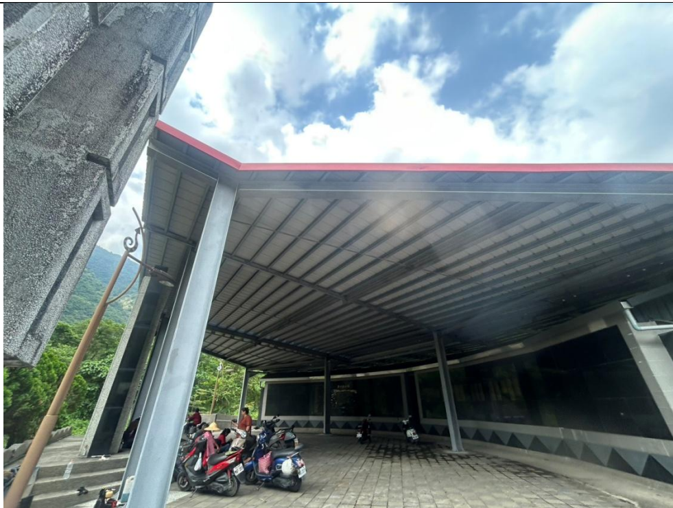
萬山里紀念公園廣場鐵皮屋頂延伸加蓋並安裝吊扇案。
