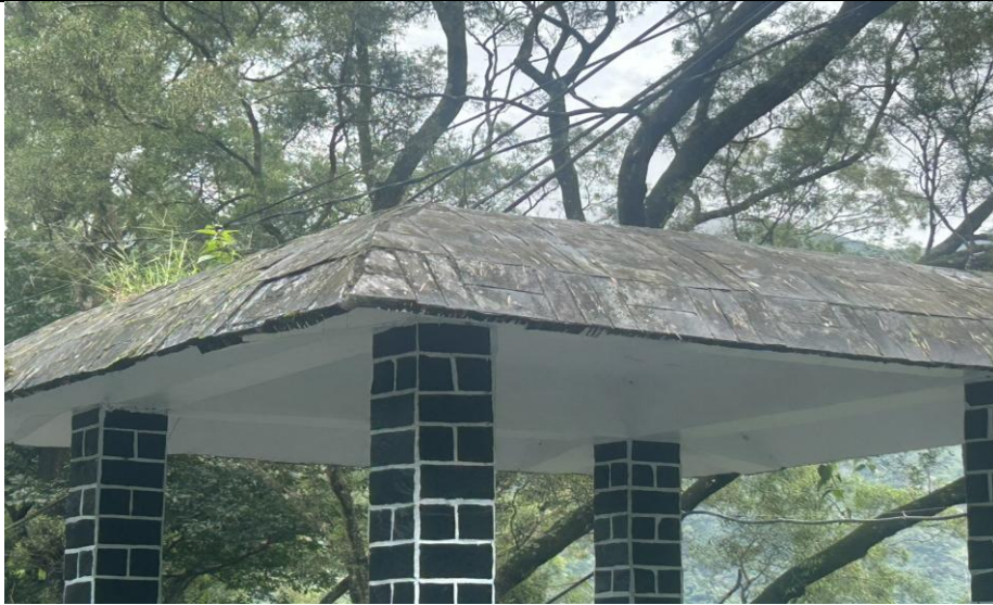
多納呼喚台入口地磚、涼亭屋頂改善案
