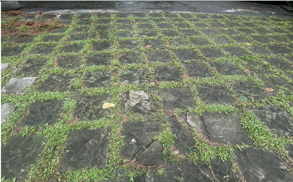
多納呼喚台入口地磚、涼亭屋頂改善案
