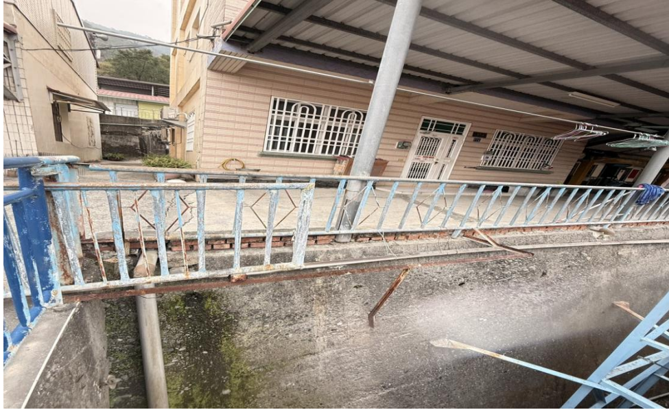
萬山里循理會上方通往第二鄰樓梯鐵柵欄門軌腐鏽汰換
