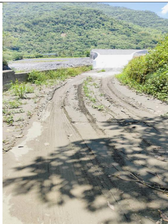
茂林二水田大排水溝出水口處道路低窪、積水土石
