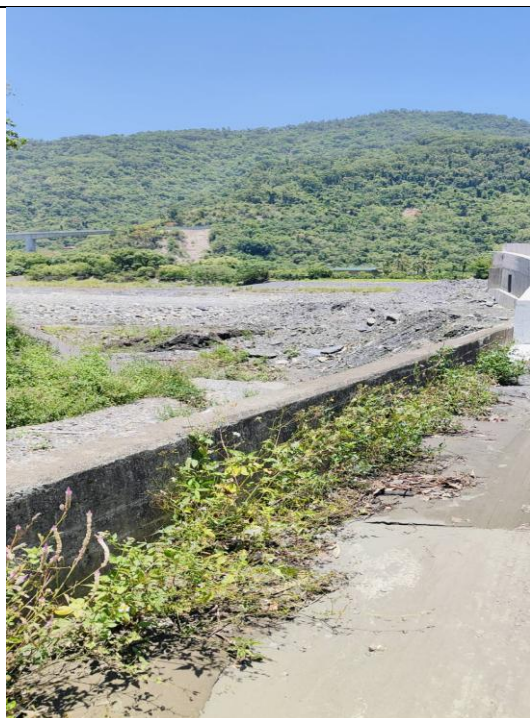
茂林二水田大排水溝出水口處道路低窪、積水土石
