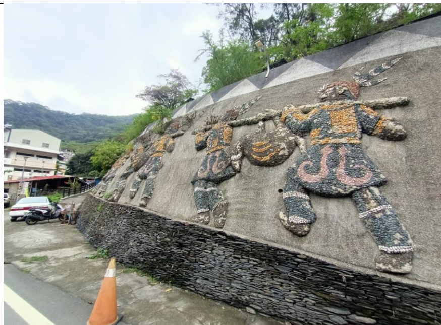
修復茂林第六鄰壁牆浮雕設施，改善環境及增加部落美感
