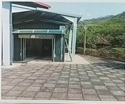
照片說明：公園外圍鐵皮屋頂
