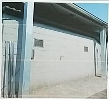
照片說明：塔位外面牆壁
